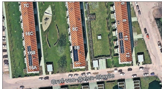
Von oben sind die Solarthermieanlagen auf den Dächern der Häuser am Kreisauer Weg, an der Graf-von-Galen-Straße und der Markus-Schleicher-Straße gut erkennbar. Visualisierung: z
